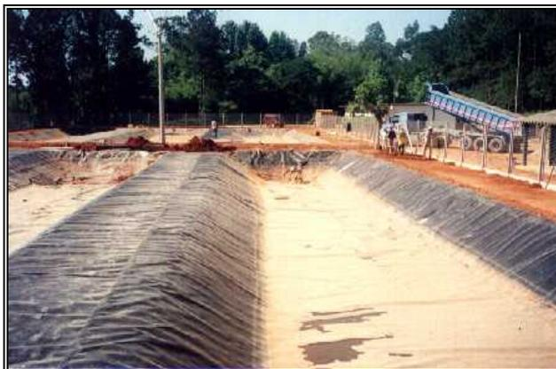
Foto2.7.4 – Tanque escavado com revestimento de geomembrana impermeável.
